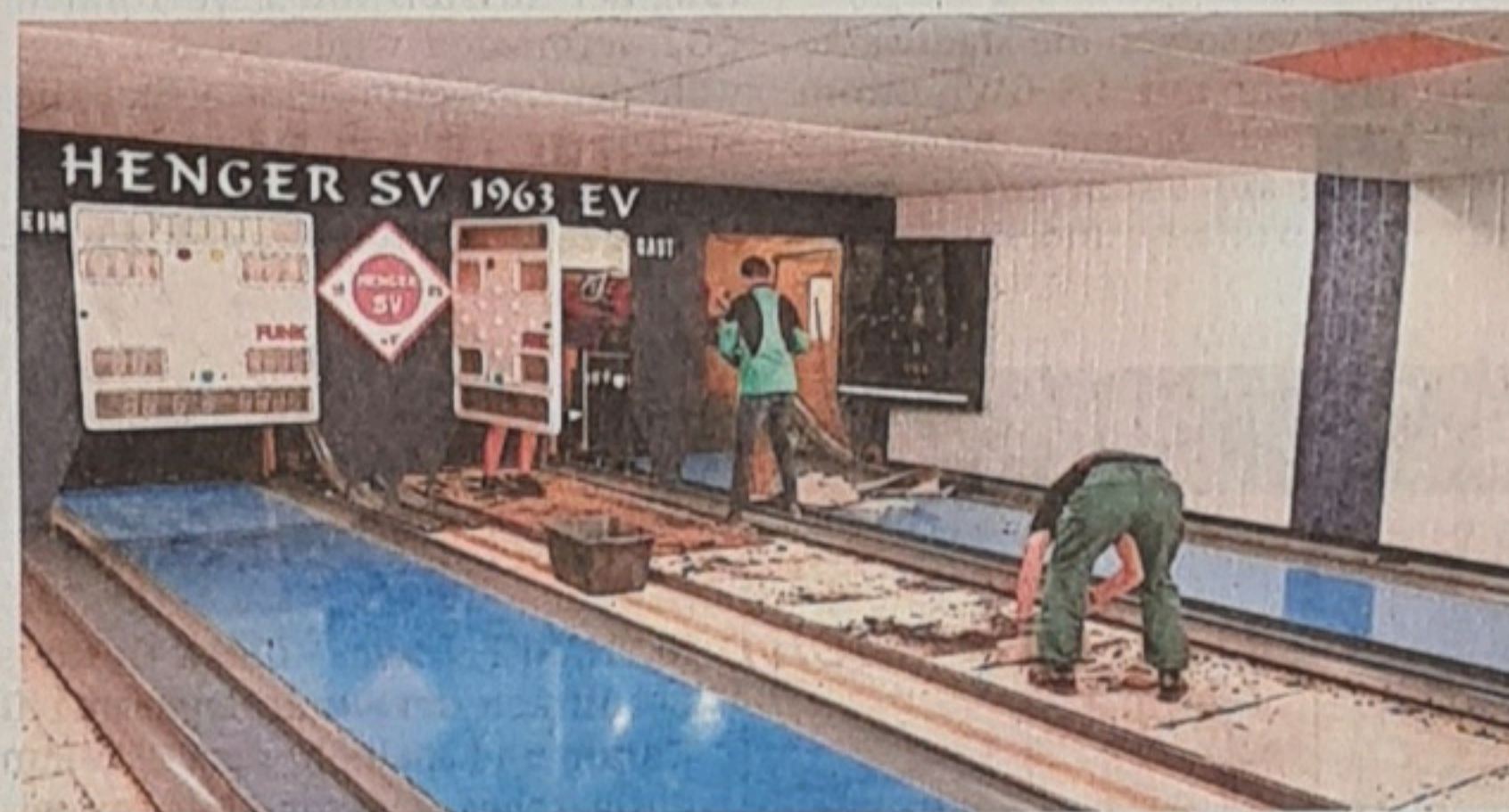
Ein Knochenjob: der Abriss der alten Kegelbahn.
